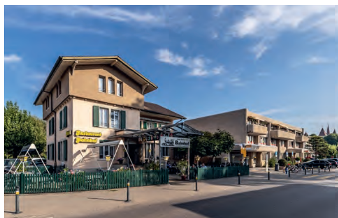
Fernwärmeanschluss Hotel-Restaurant Bahnhof, Murten
